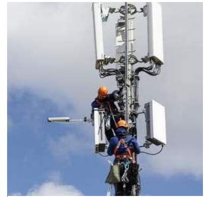
Foto: Installation von 5G-Sendern
